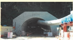
▲R158奈川渡改良2号トンネル
